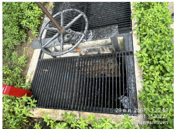
ภาพที่ 49 บ่อรับน้ำเพื่อตกตะกอน
