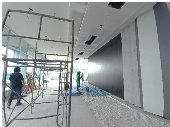
ภาพที่ 69 ใช้นั่งร้านตามมาตรฐานขณะทำงานบนที่สูง
